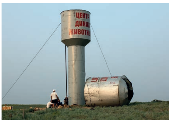
Рис. 26. Установка водонапорной башни Рожновского в питомнике «Яшкульский» (фото Ю.Н. Арылова).
